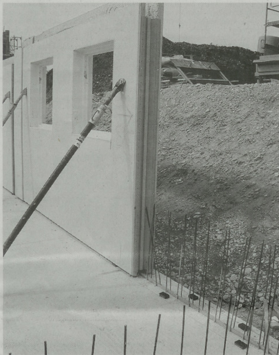
Der Einsatz des Dryset Sollrisselementes, über die gesamte Konstruktionsbreite. Foto: Drytech
