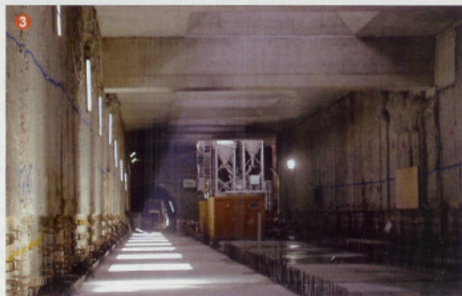
Bei der Erweiterung der Münchner U-Bahn, dem neuen Bahnhof – Olympiapark-Nord wurden 700 m Schlitzwand- und Sohlbalkenfugen dauerhaft abgedichtet.
