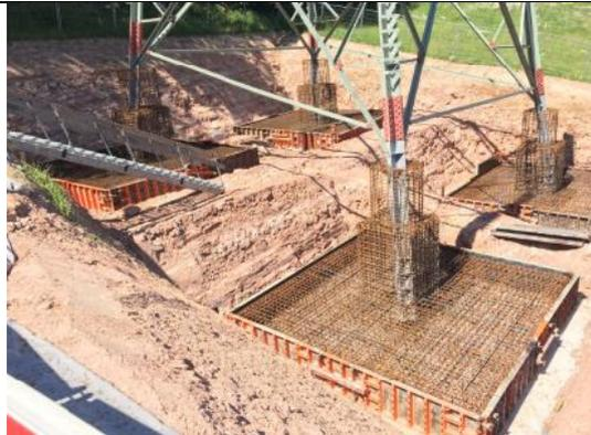
Vier abgestufte Einzelfundamente für einen Höchstspannungsleitungsmast, geschalt mit der Wandschalung LOGO.3.
