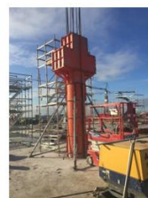
Stütze D.80x539cm mit 2 Auflagerkonsolen „Kopfform 3“
