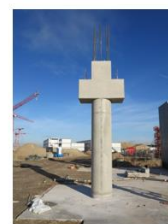
Stütze D.80x539cm mit 2 Auflagerkonsolen „Kopfform 3“
