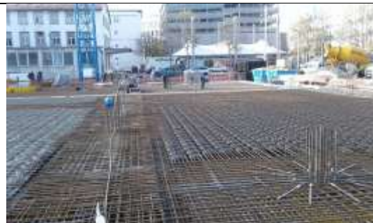
Beim Projekt in der Zielstattstraße 27 wurden zum Erzielen großer Deckenspannweiten und Stützenraster auf insgesamt 13.200 m 2 Deckenfläche ca. 68.500 Slim-Line-Hohlkörper verlegt und einbetoniert.
