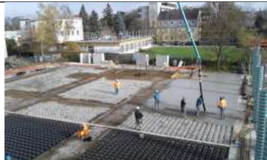
Die Slim-Line-Hohlkörper auf der Erdgeschossdecke des Projektes „Zielstattstraße 27“ werden einbetoniert.
