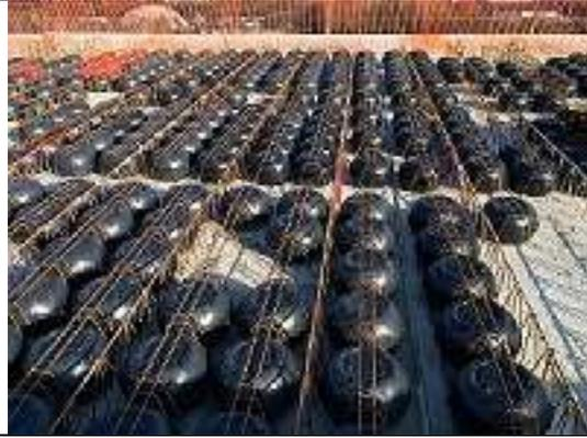
Der Einbau der oberen Bewehrungslage und das anschließende Betonieren unterscheiden sich nicht von der herkömmlichen Ausführung.
