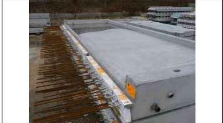
Cobix-Hohlkörper fertig eingebaut in der Schalung und zum Betonieren bereit.
