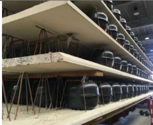
Cobias-Hohlkörpermodule kombiniert mit Elementdecken.
