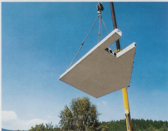
Die Verlegung erfolgt meist mittels Montagekran direkt vom Transportfahrzeug.
