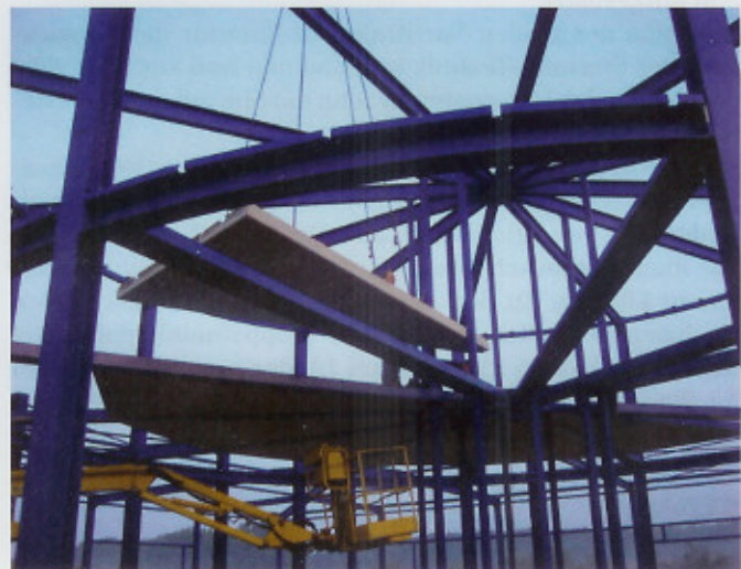
Dennert macht vor Sonderelementen nicht halt. Deckenplattenfertigteile für ein Fitnessstudio werden eingeschwebt. Fotos: Dennert KG
